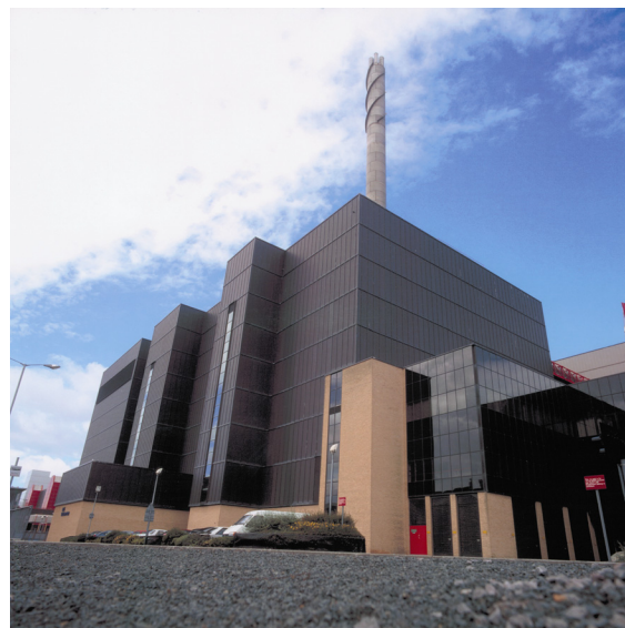
Figur 4: Vitrifiseringsanlegget (foto: BNFL).
