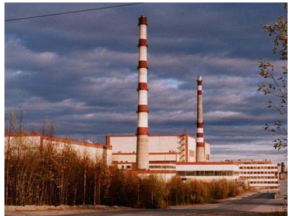
Kola kjernekraftverk (Foto: Statens strålevern).
