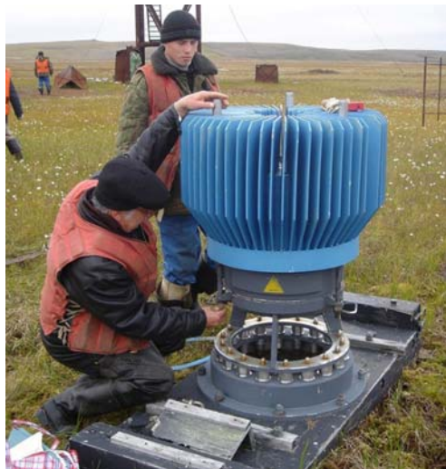
Демонтаж РИТЭГа в месте расположения на северо-западе России (Фото: Губернатор губернии Финнмарк).
