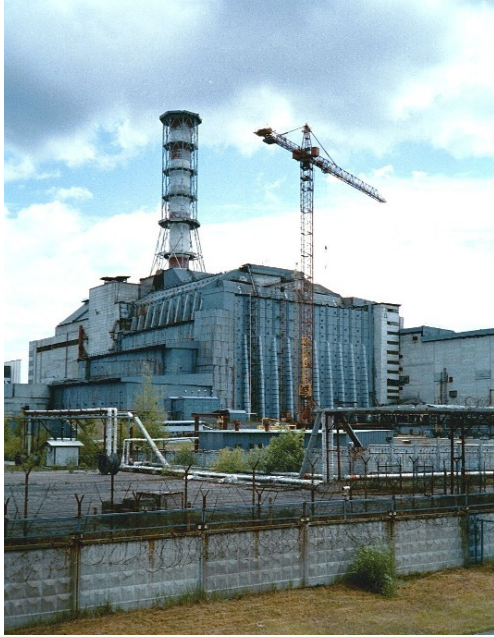
Reaktor 4 i Tsjernobyl - etter ulykken og etter innbygging i sarkofag (foto: Statens strålevern).
