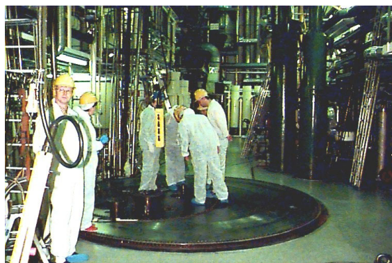
Strålevernet utfører inspeksjon av reaktorlokket i fjellanlegget i Halden (foto: Statens strålevern).
