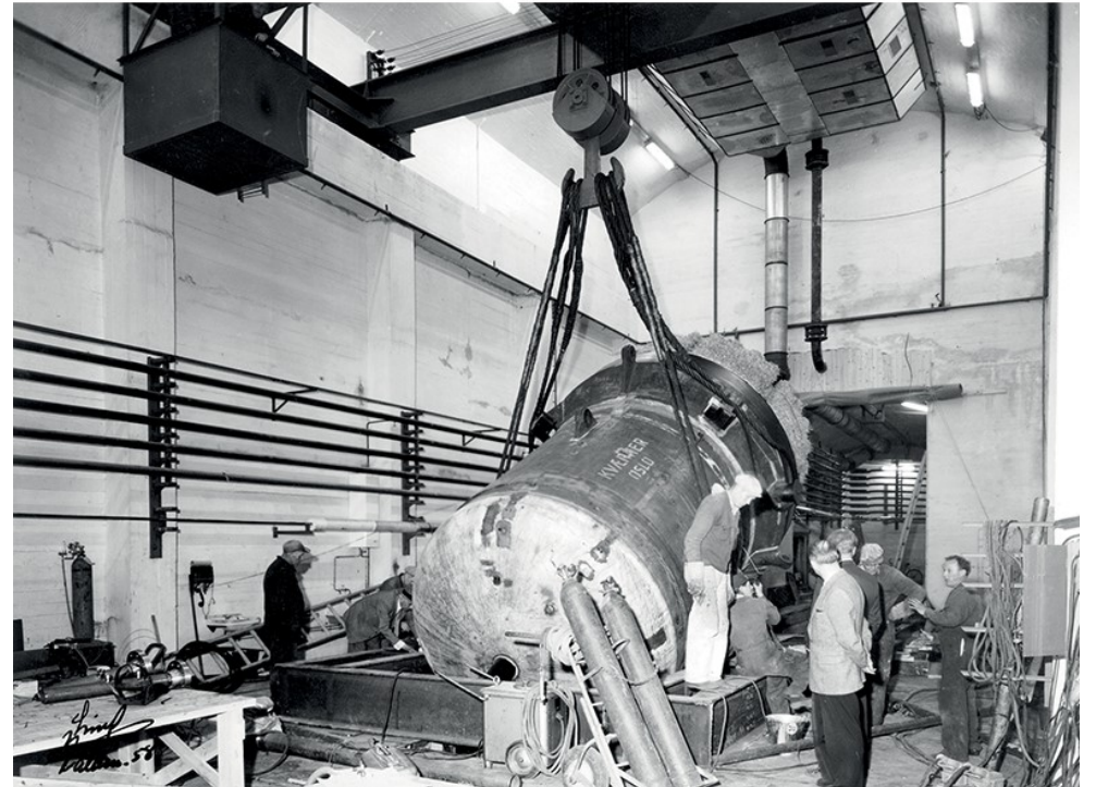
Reaktortanken i Halden heises på plass (Foto: IFE)
