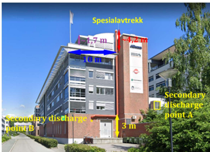
Figur 3: Fasaden i Gullhaugveien 7, med de tre utslippspunktene.
