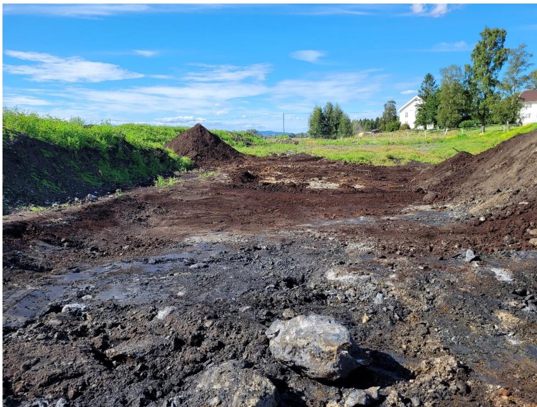
Figur 8. Området vest for anleggskulvert ved Fokholgutua etter avtak av matjord. De brune torvmassene er «myrområde» som tidligere har vært dekket til med matjord og forsøkt dyrket.
