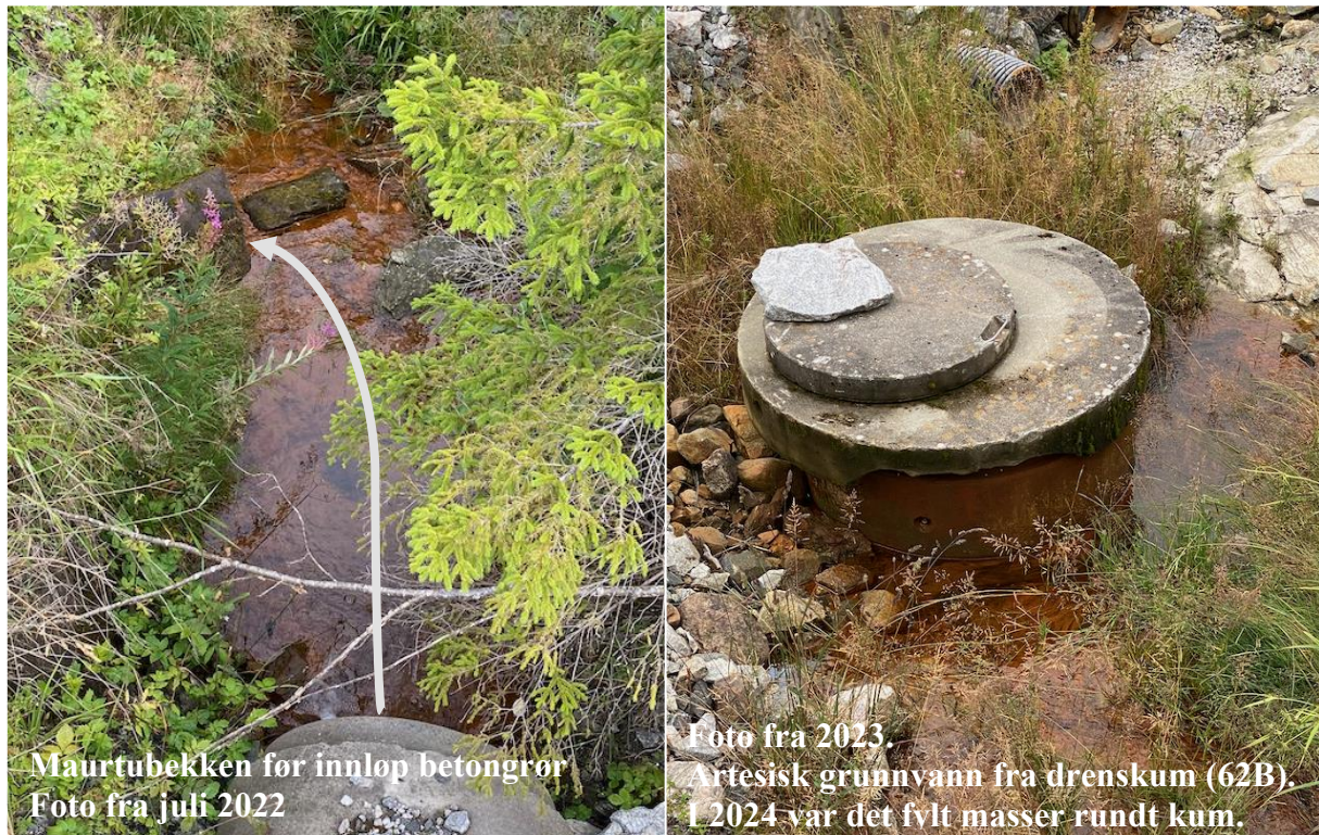
Figur 2. Maurtubekken, Feltundersøkelse 1: Bildene viser punkt F1 og F2 NØ i figur 1. F1 viser drenskum (62B) og F2 viser bekk like nedstrøms kum, før bekken renner i betongrør gjennom underbygningen til Maurtuveien. Feltundersøkelse 1: Gammespektrometriske målinger er utført i området ved kummen.
