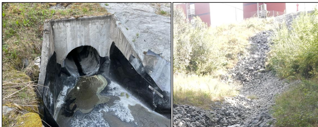
Figur 3-4. Innløp Myrerbekken i midlertidig rør (til venstre). Utløp av Myrerbekken går i en steinfylling nedstrøms Vefald-tomta (til høyre)
