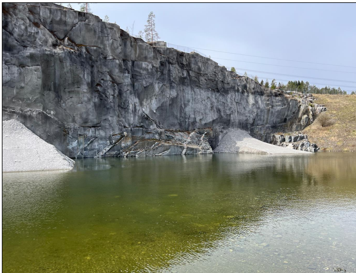
Figur 3-5. Dammen som ligger på Low area etter at senking av grunnvannstanden ble stanset.
