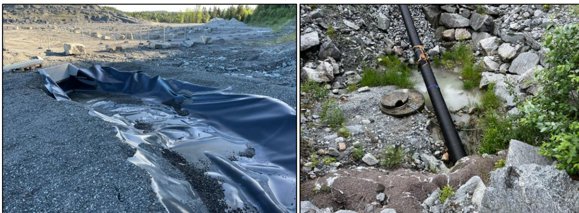
Figur 3-2. Innløp av Mautubekken i midlertidig rør (til venstre). Utløpskum for sigevann (til høyre).
